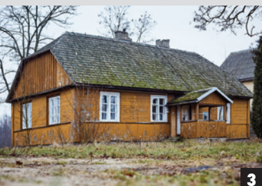
3 Dach naczółkowy, kryty gontem, Kuflew, gm. Mrozy
