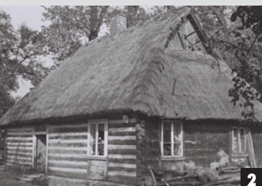
2 Dach przyczółkowy, Starogród, gm. Siennica, lata 60 XX w. BMP
