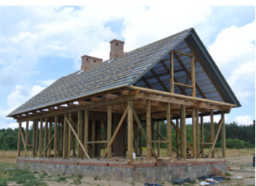
Szkielet domu w konstrukcji ryglowej
