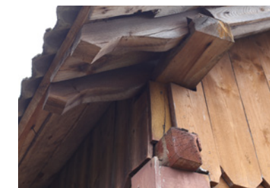
Konstrukcja ze ścianą kolankową, Ponurzyca, gm. Celestynów
