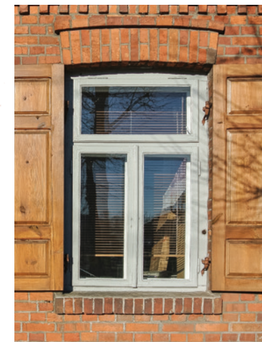
Okno skrzynkowe w budynku ceglany, Kołbiel
