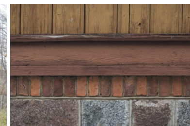
Widok elewacji oszalowanego domu zrębowego na kamiennym fundamencie z łamanego kamienia
