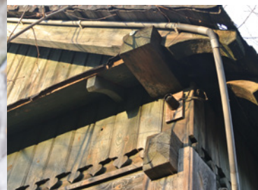
Konstrukcja ze ścianą kolankową, Czarnowiec, gm. Osieck
