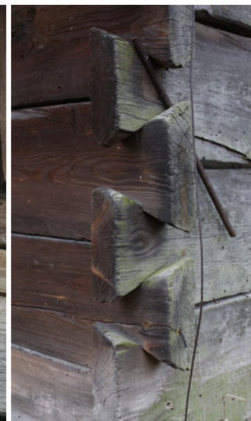
Zawęgłowanie naroży w konstrukcji zrębowej
