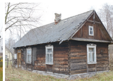
Dom w konstrukcji zrębowej, Czarnowiec, gm. Osieck
