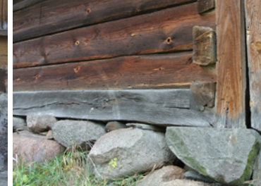
Osadzenie zrębu budynku na fundamencie z okrągłych kamieni, Czarnowiec, gm. Osieck
