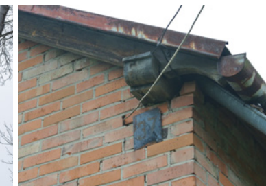
Konstrukcja ze ścianą kolankową, Czarnowiec, gm. Osieck
