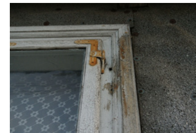
Oblistwowanie okna, Osieck, gm. Osieck
